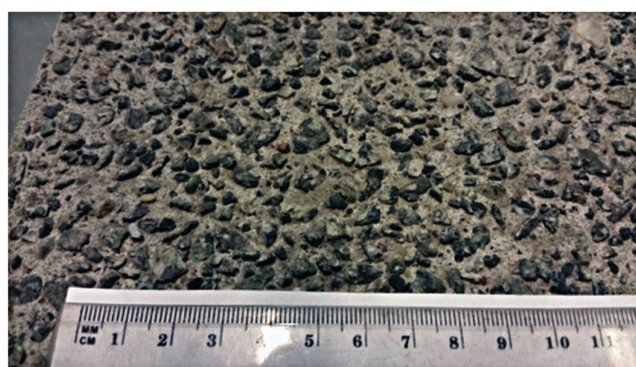
Rys. 1. Powierzchnia próbki betonowej z odkrytym kruszywem
